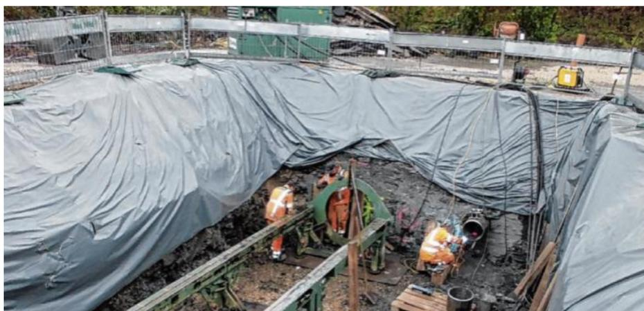
Mit diesem Spezialtiefbau werden die Leitungen unter die Bahngleise und unter die Straße vom Kreisverkehr Streichhoffeld bis zum Kreisverkehr Stockert gezogen.
